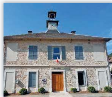
... et après travaux
