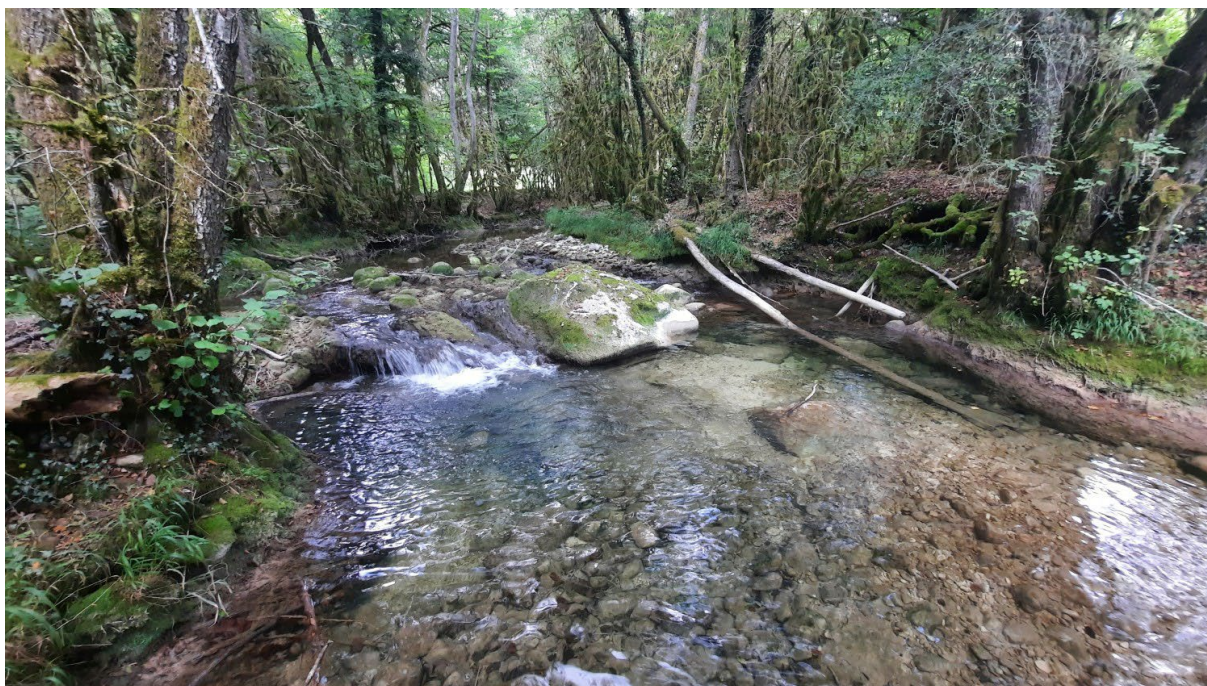
L'Arvière en amont de Vaulx-Morets (photo : Améten, 2021)
