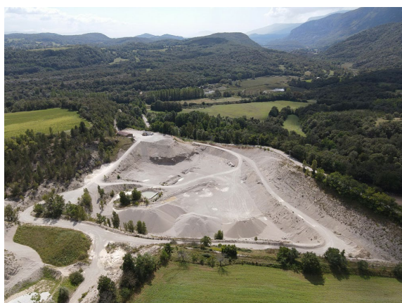
Site : 0061.07033 Conditionnement déchets béton (photo : Améten, 2021)
