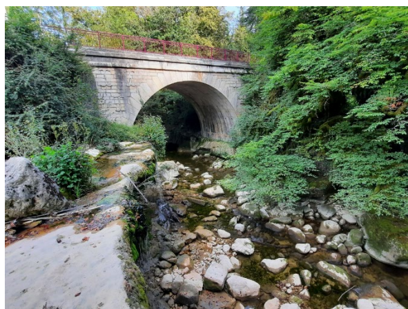
Pont de la Faverge (photo : Améten, 2021)
